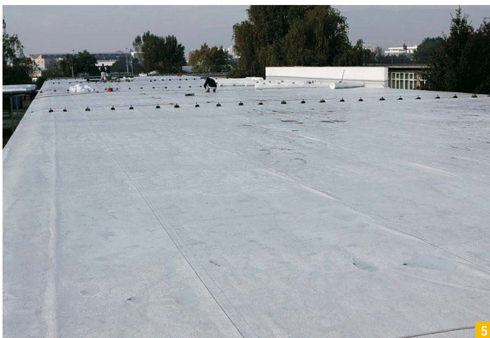
Slika 5: Krov tvornice s položenim Mapeplan-om.
