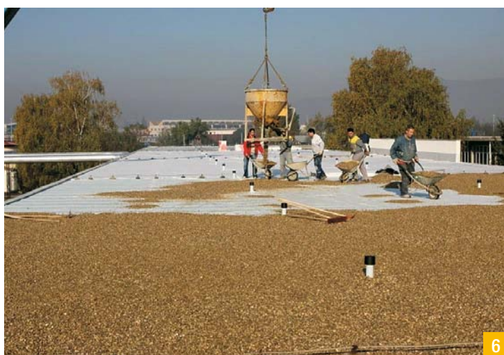
Slika 6: Posljednja faza radova – posipavanje šljunka na foliju Mapeplan B.
